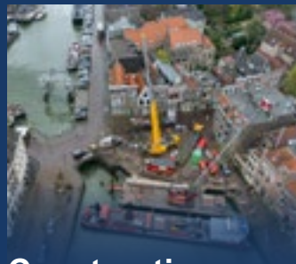
Constructies en Geotechniek
