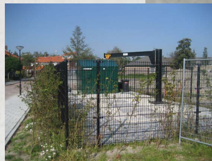
Een van de rioolgemaal in Zwijndrecht.
